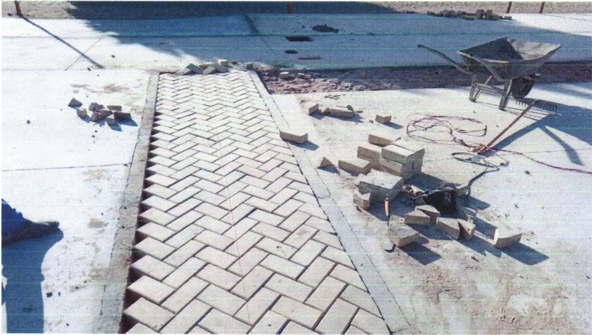
Foto 03 - Pavimentação em bloco de concreto vibroprensado, intertravado, colorido, 10x20cm, e=6cm, 46un/m 2 , NBR9781, Fck(min)=35MPa, sob coxim areia grossa compactada c/ placa vibratória, e(comp.)=6cm, rejuntado c/ areia fina.
