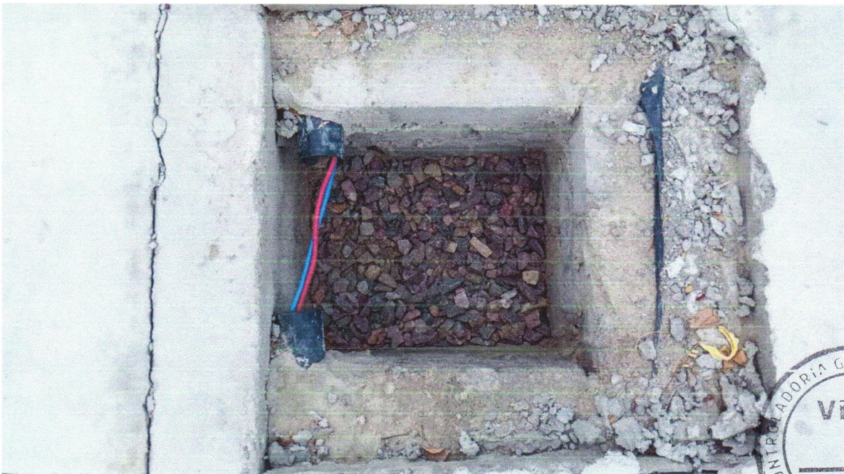
Foto 08 - CABO DE COBRE ISOLADO HEPR (XLPE), RIGIDO, 16MM 2 , 1KV/90°C
