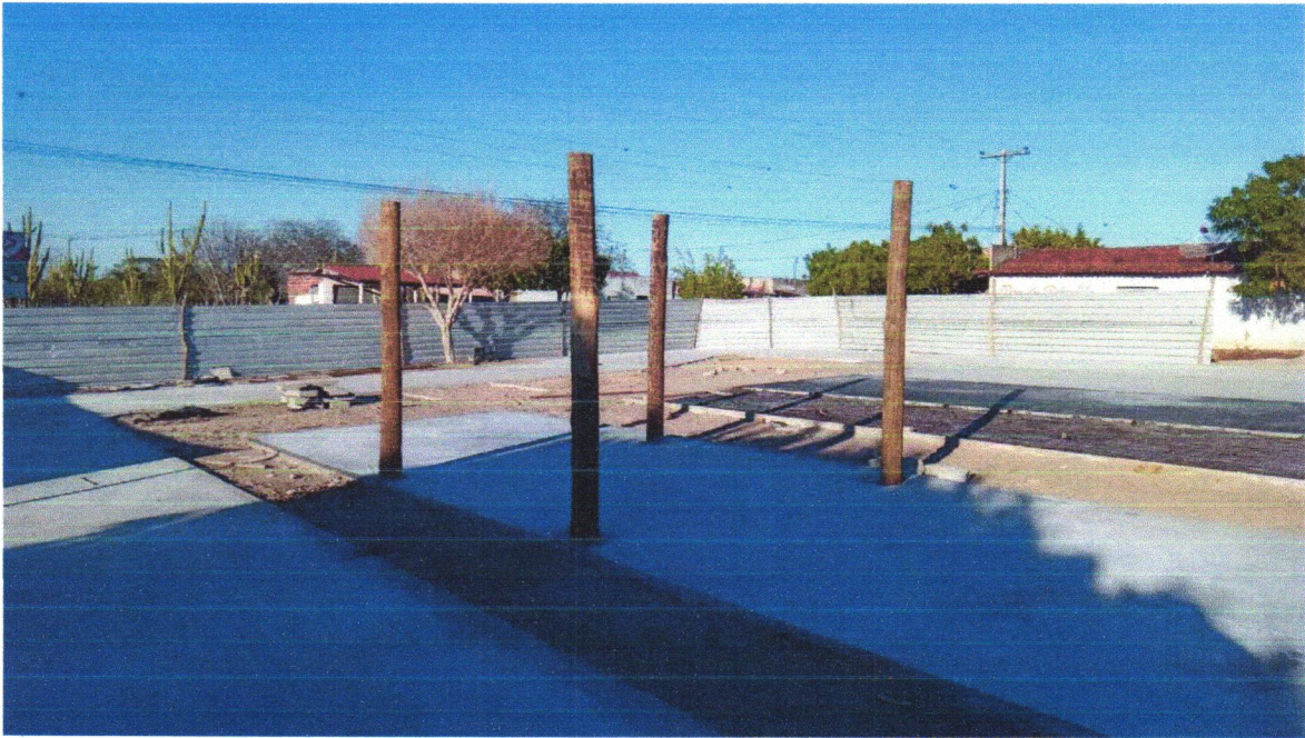
Foto 07 - FORNECIMENTO DE PEÇA DE EUCALIPTO TRATADO, D= 19 A 22CM, L= 4,00 M (MOURÕES)
