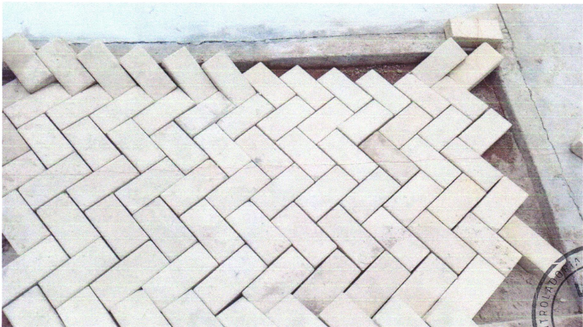
Foto 04 - Pavimentação em bloco de concreto vibroprensado, intertravado, colorido, 10x20cm, e=6cm, 46un/m 2 , NBR9781, Fck(min)=35MPa, sob coxim areia grossa compactada c/ placa vibratória, e(comp.)=6cm, rejuntado c/ areia fina.
