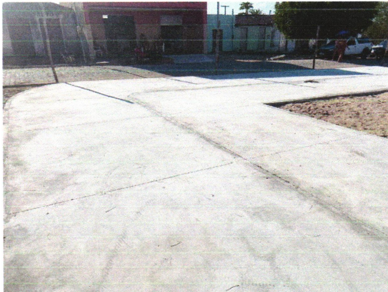
Foto 01 - PAVIMENTAÇÃO EM CONCRETO, COM ESPESSURA DE 7 CM, COM ACABAMENTO FEITO UTILIZANDO ALISADORA DE CONCRETO (HELICOPTERO), INCLUIDO TELA DE AÇO SOLDADA NERVURADA CA60, Q196 (3,11 KG/M2), DIAMETRO DO FIO 5.0 MM, LARGURA = 2,45 M, ESPAÇAMENTO DA MALHA = 10 X 10 CM, JUNTA DE DILATAÇÃO EM PVC A CADA 2,00 M, CONCRETO FCK = 20 MPA
